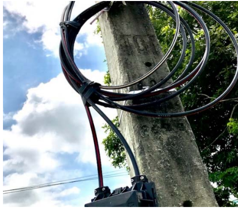
ภาพประกอบที่ 3. สภาพสาย ADSS Anti Rodent Flat FRP ตัวอย่างติดตั้งจุดที่ 1.
