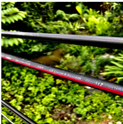
ภาพประกอบที่ 4. สภาพสาย ADSS Anti Rodent Flat FRP ตัวอย่างติดตั้งจุดที่ 2.
