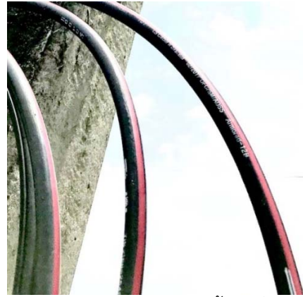
ภาพประกอบที่ 3. สภาพสาย ADSS Anti Rodent Flat FRP ตัวอย่างติดตั้งจุดที่ 1.
